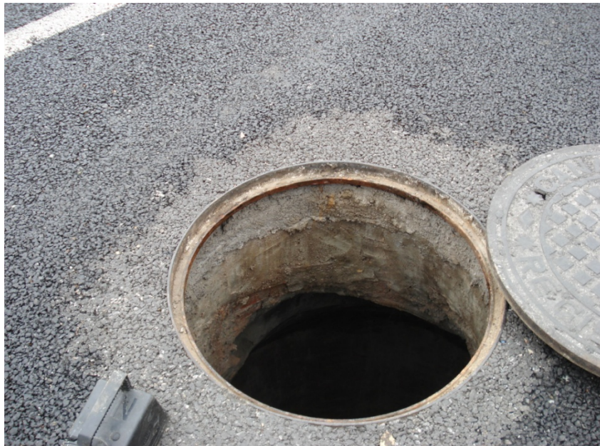
DETALLE DE POZO DE ACCESO DE PERSONAL.
