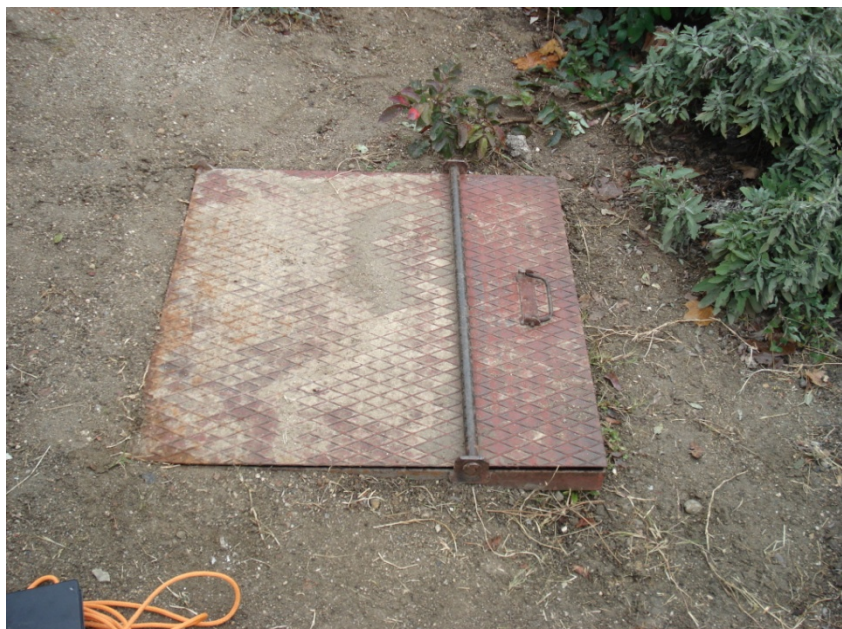
DETALLE DE POZO DE ACCESO DE PERSONAL
